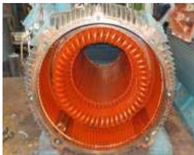
Gambar 4.3 Kondisi Stator setelah overhaul
